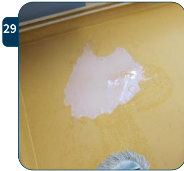
29 Giet een kleine plas Floor Seal op de vloer. Gebruik ongeveer 1 liter product per 30m 2 .
