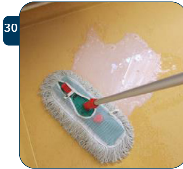
30 Drenk de klamvochtige mop in de plas zodat deze verzadigd is met Floor Seal.
