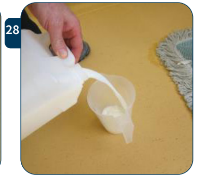
28 Giet Floor Seal in de maatbeker. Zo kan je makkelijker het product op de vloer verdelen.
